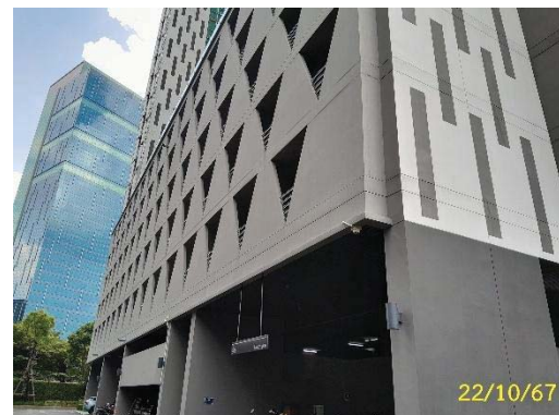
ช่องเปิดระบายอากาศลานจอดรถ
