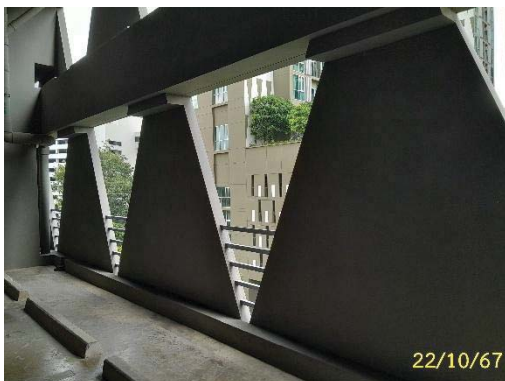
ช่องเปิดระบายอากาศลานจอดรถ
