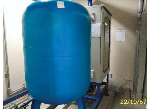
ปั๊มระบบถังอัดแรงดัน (Booster Pump)
