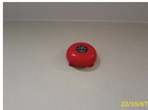
กระดิ่งสัญญาณ (Fire Alarm Bell)
